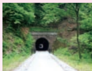
手前9号、その奥に8号トンネル
